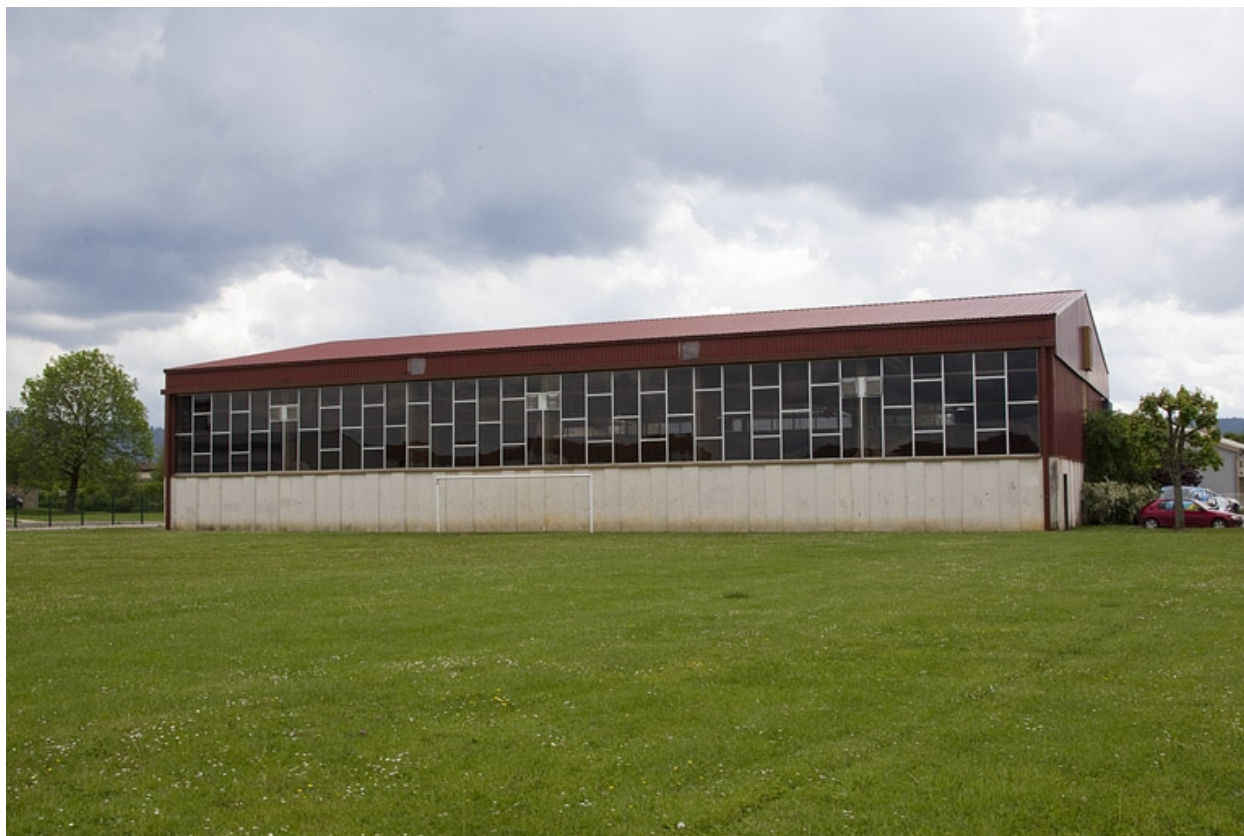
Grand gymnase occidental, vu du nord.
