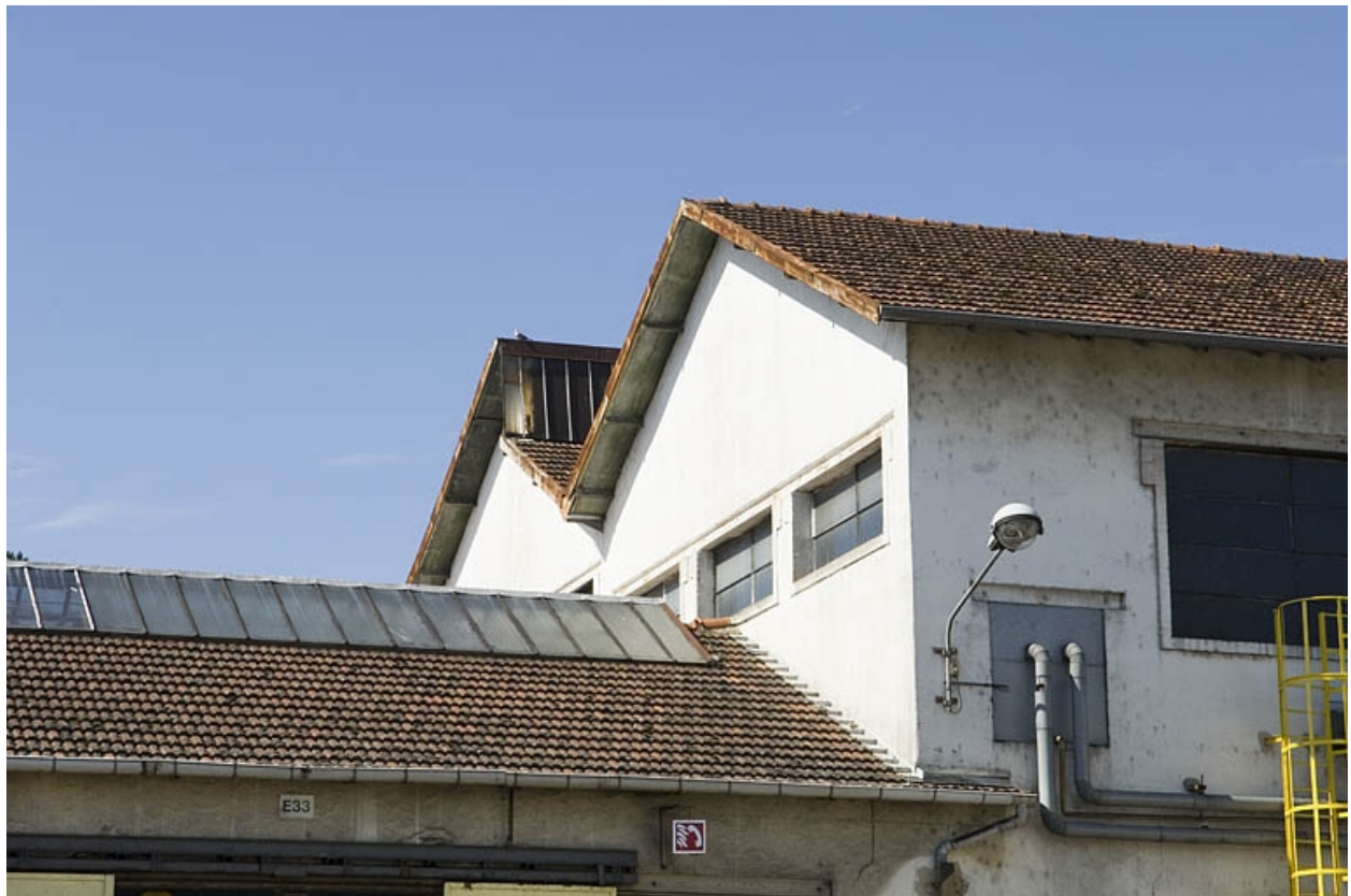
Toiture d'un magasin industriel.
