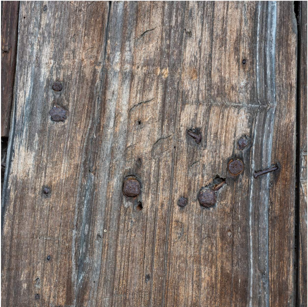
Détai du vantail de la porte de remise.
