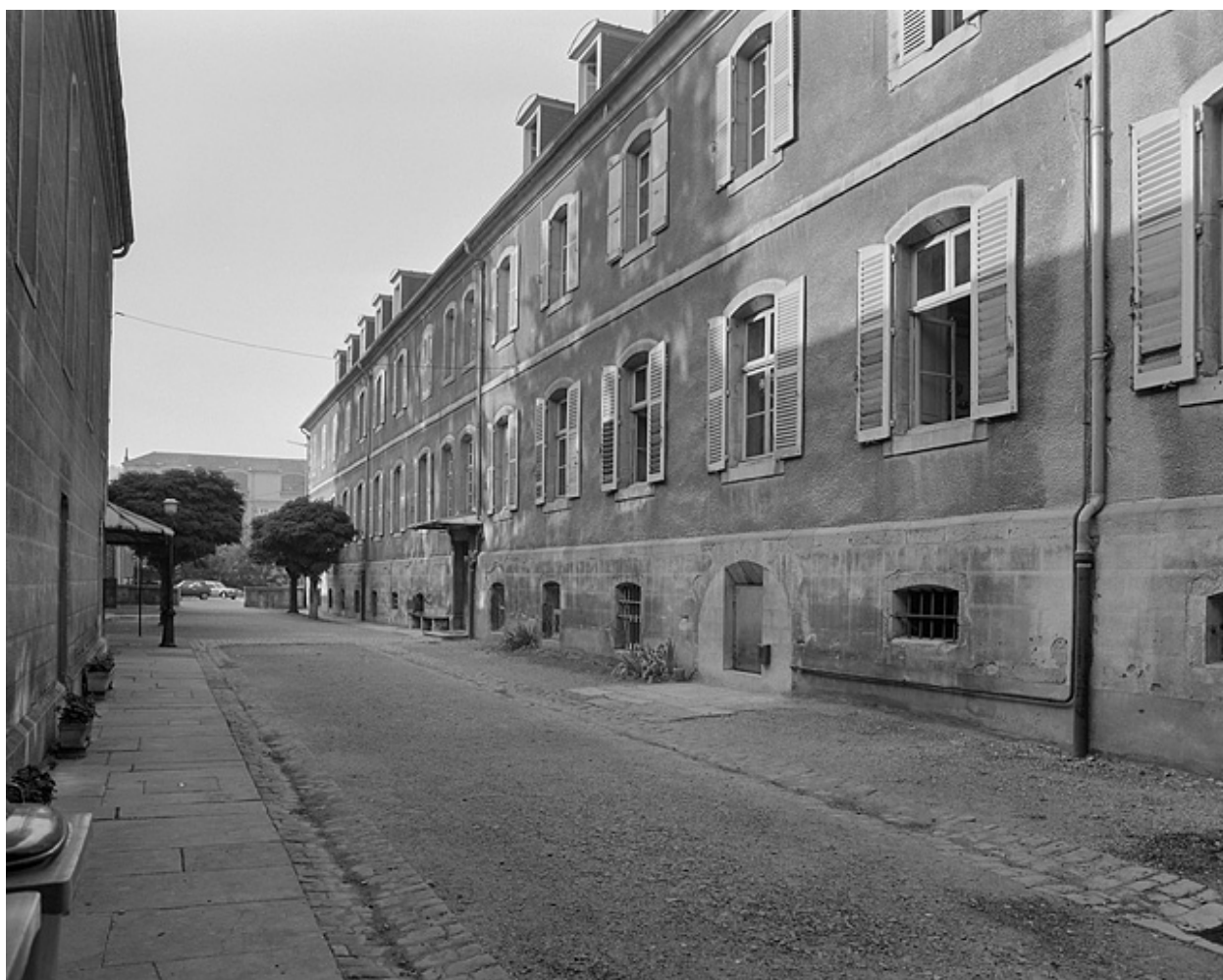
Bâtiment principal, façade sur la cour.
