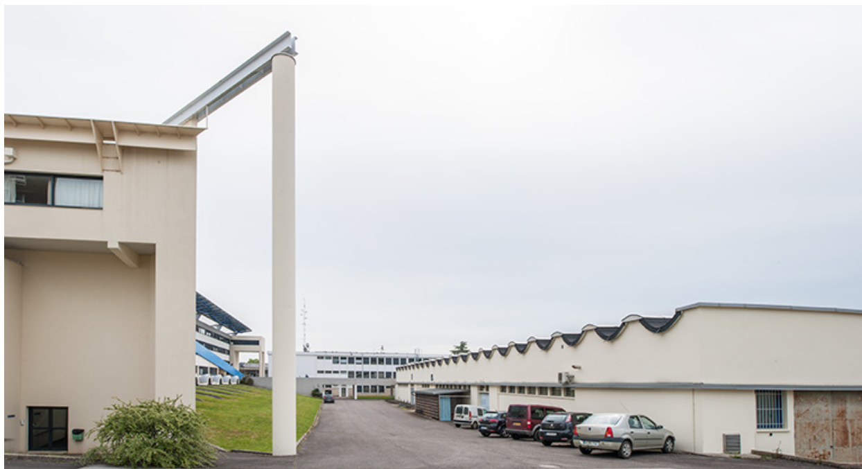
Ateliers : façade antérieure.
