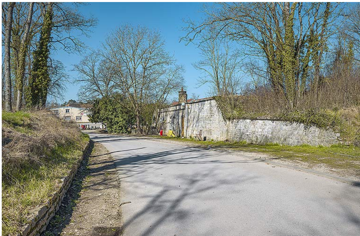
Vue de trois quarts du front de gorge.
