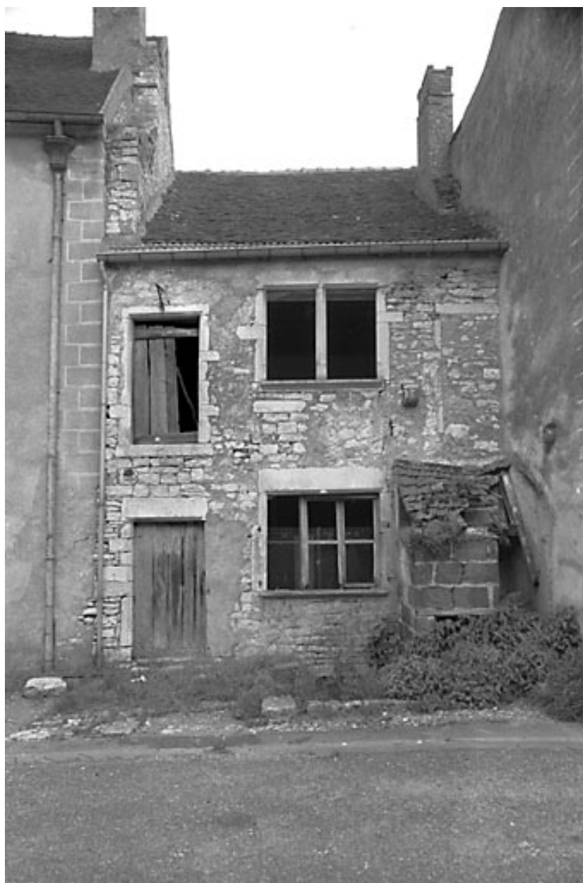
Maison située rue Gollu : façade antérieure.
