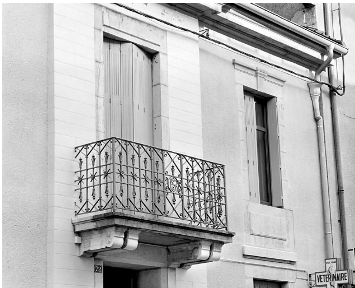
Façade antérieure : balcon et baies de l'étage.
