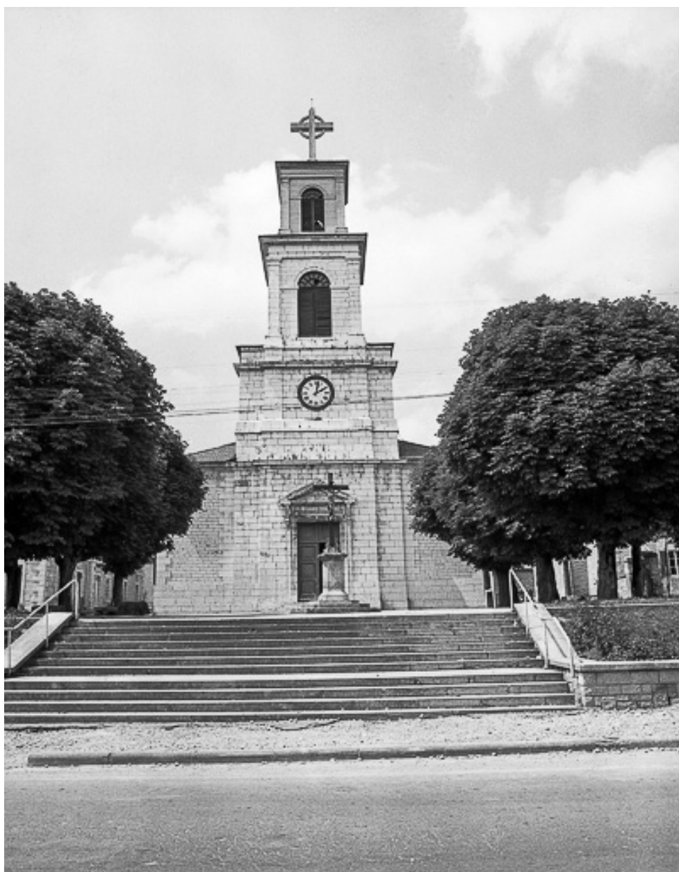
Extérieur : face antérieure.
