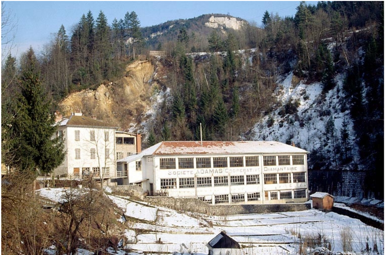
Vue d'ensemble depuis l'ouest, en hiver.
