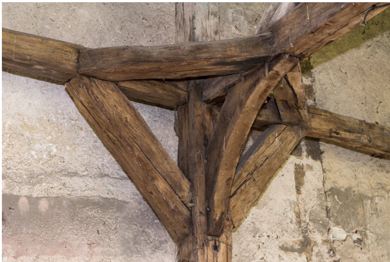
Ancienne halle : détail de la charpente.
