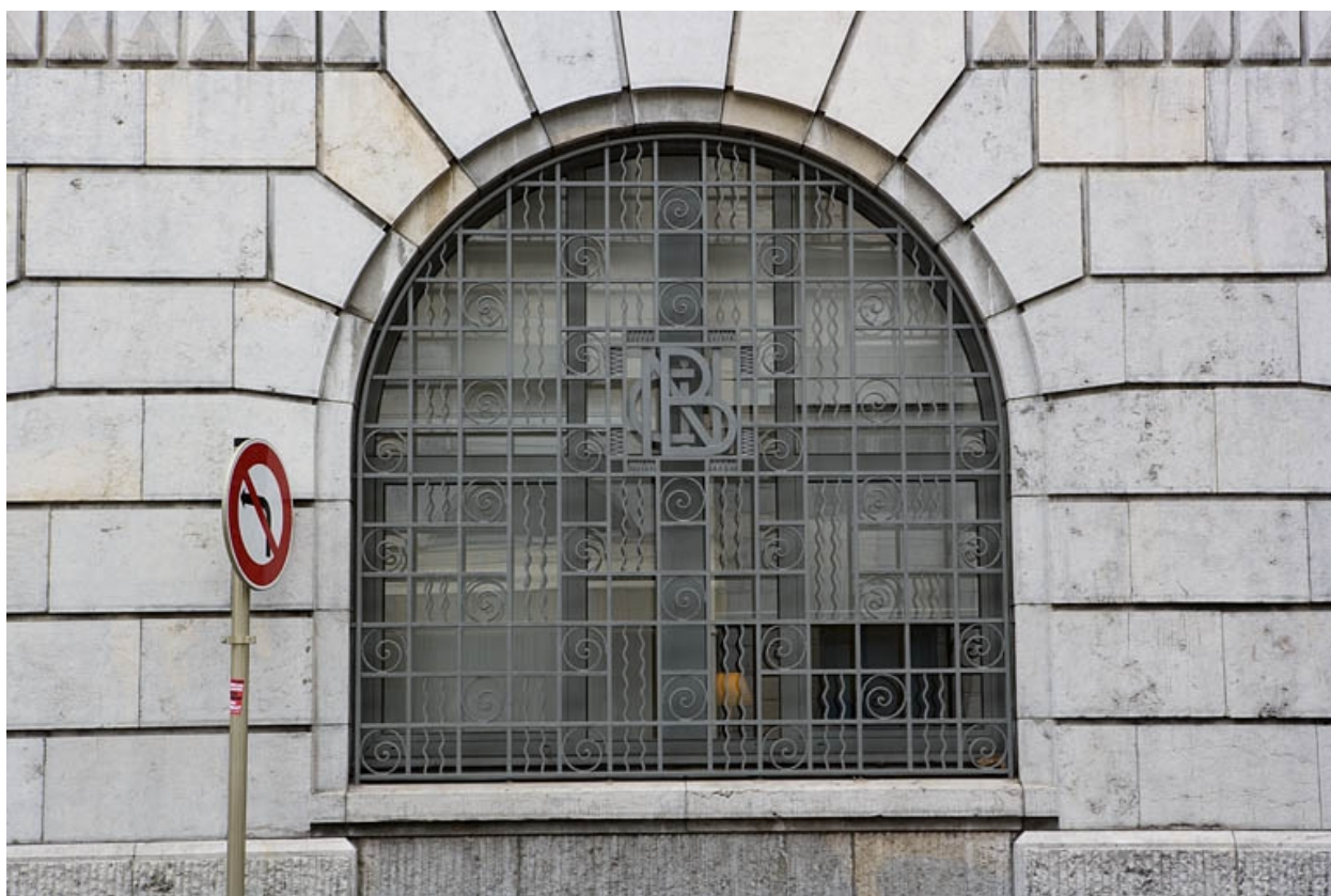
Détail d'une fenêtre du rez-de-chaussée.
