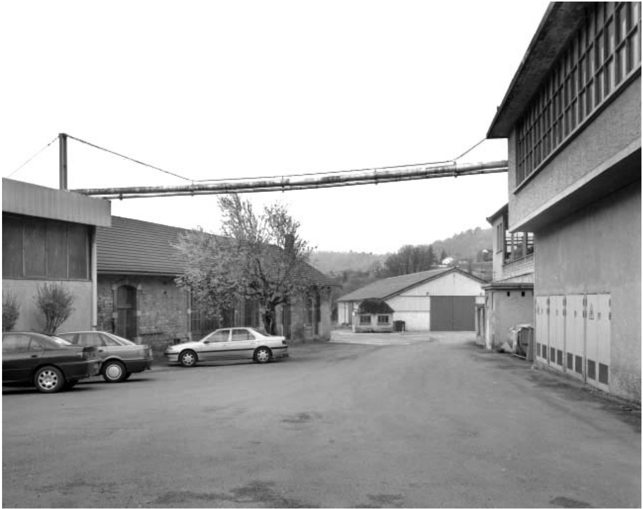
Vue des ateliers depuis les bureaux.
