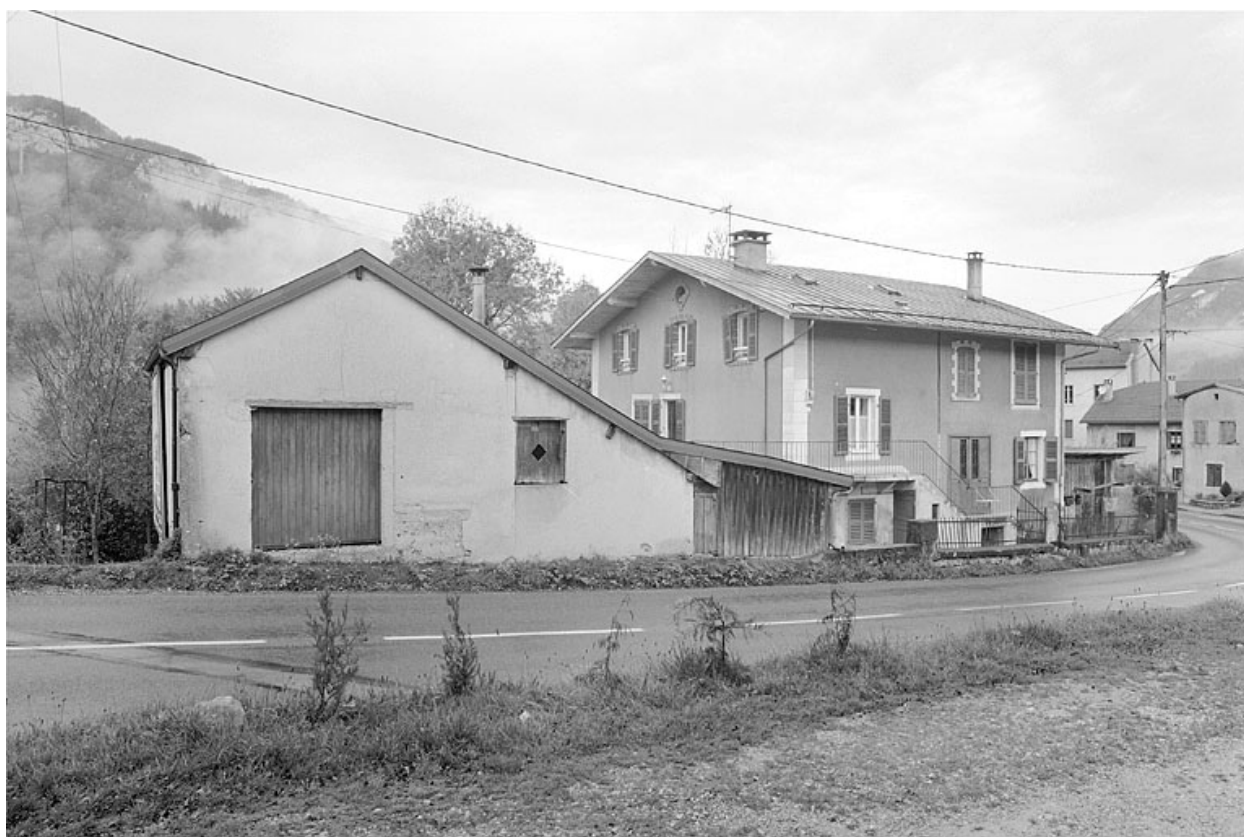
Vue générale du bâtiment et de ses annexes.
