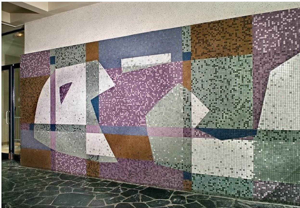
Mur du hall d'entrée.
