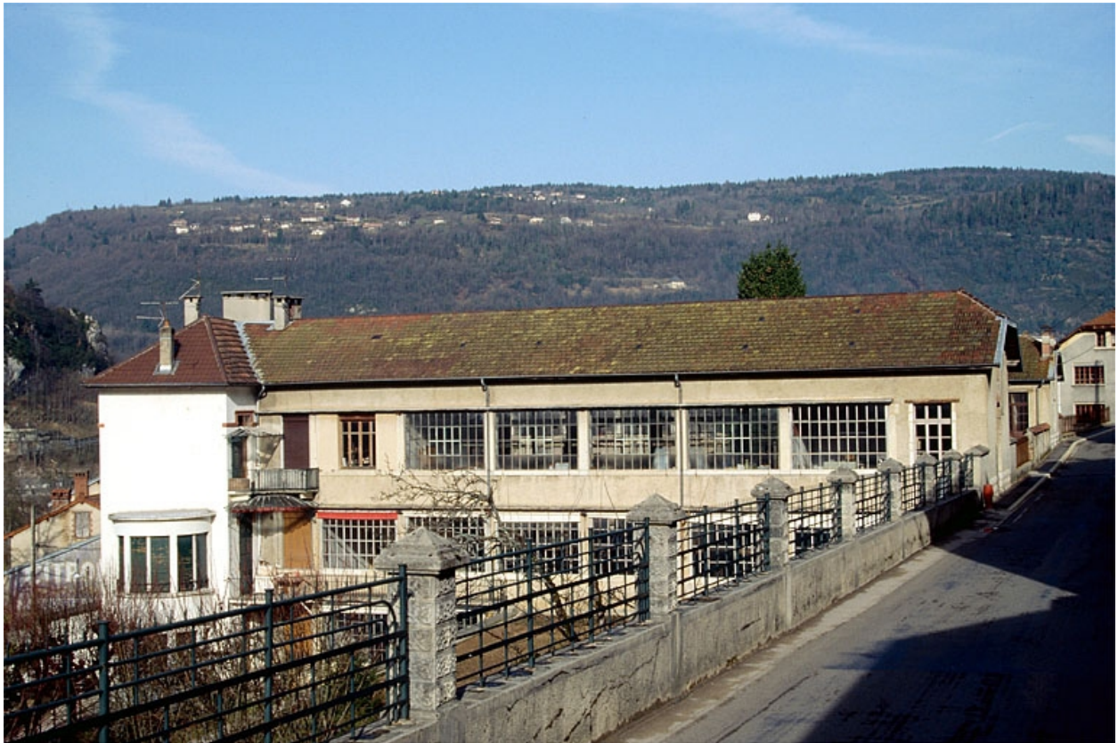
Façade latérale droite du 2e bâtiment.
