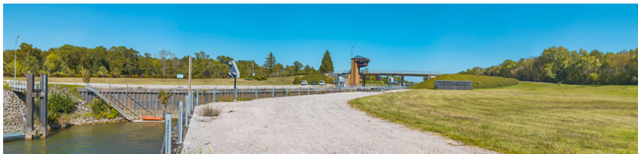
Vue d'ensemble d'aval.
