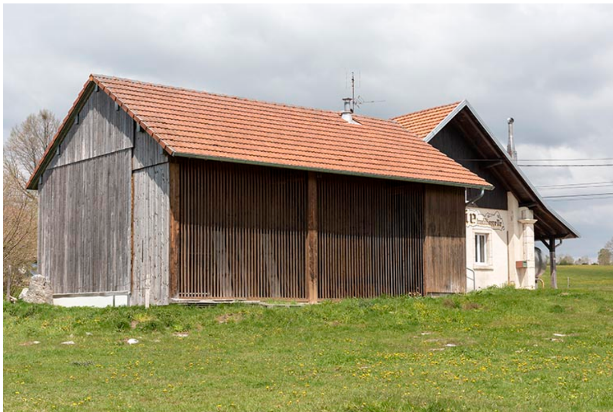
Pièce d'affinage récente, depuis le sud-ouest.
