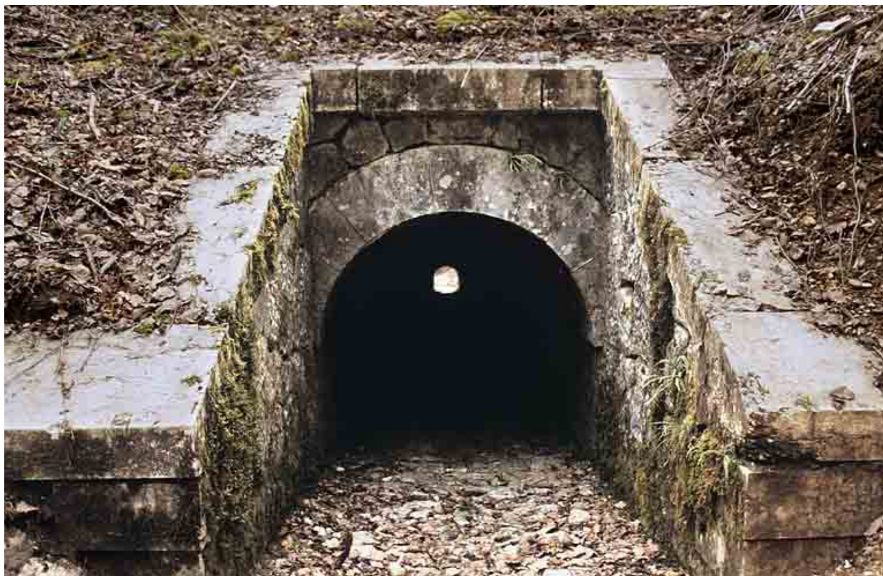
Aqueduc : tête amont (est).
