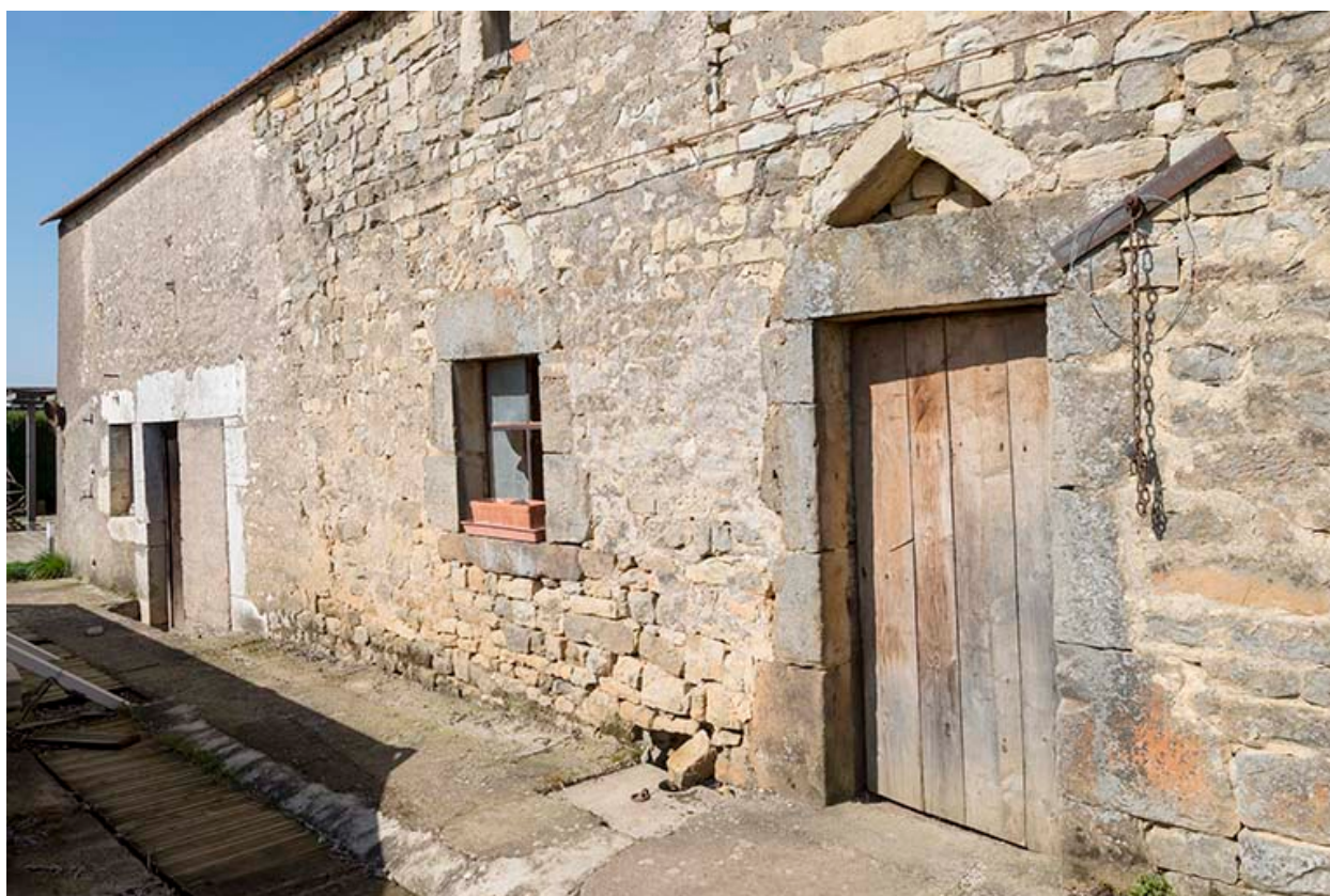
Façade postérieure de la maison.
