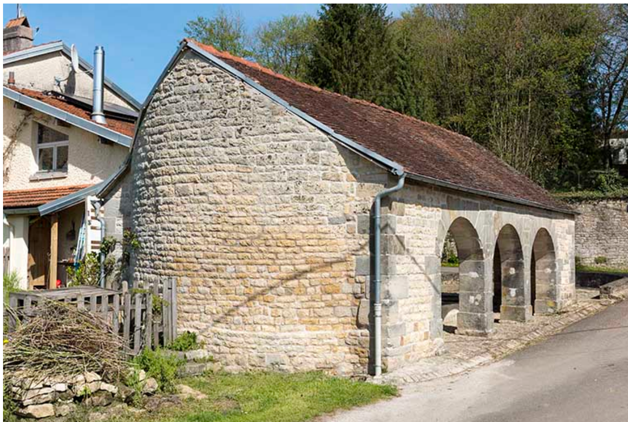
Mur pignon du lavoir.
