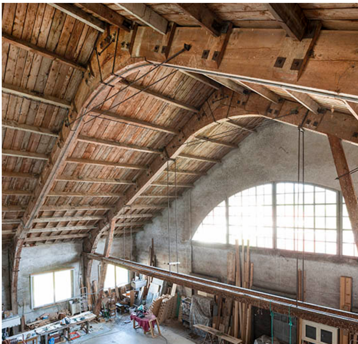
Scierie communale, Remoray-Boujeons : rare charpente en lamellée-boulonnée.
