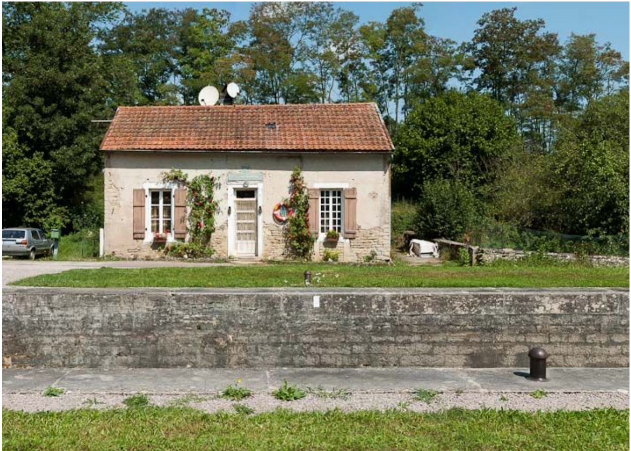
Vue de face de la maison éclusière.
