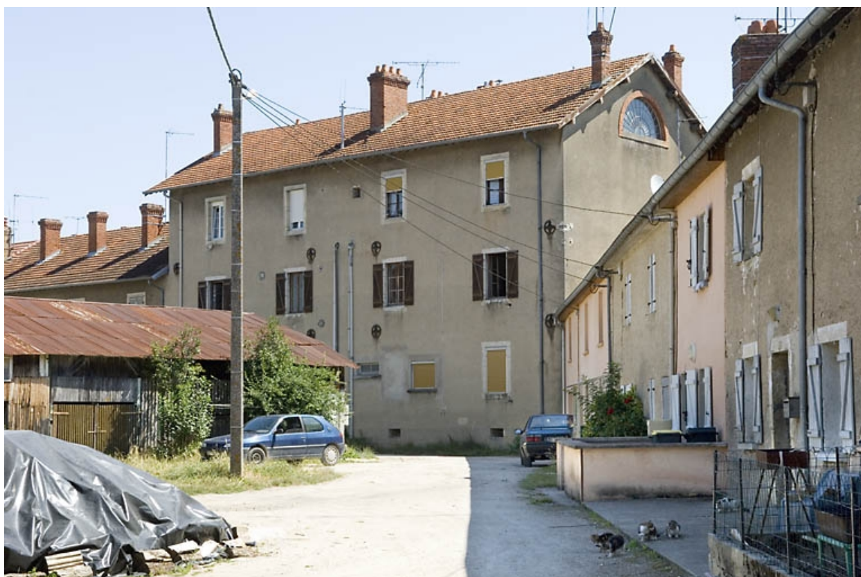
Façade ouest du logement ouvrier sur cour.
