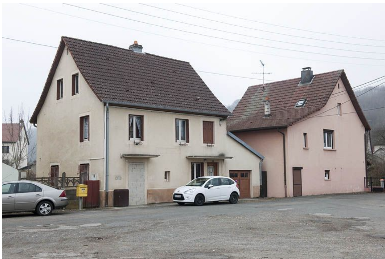
Maisons individuelles rue de la Poste.
