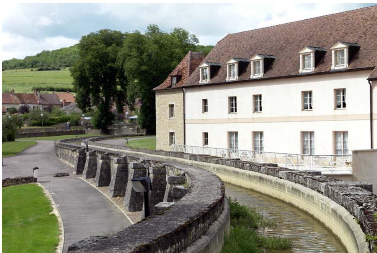
Passage ouvrage à proximité du château de Chailly-sur-Armançon.
