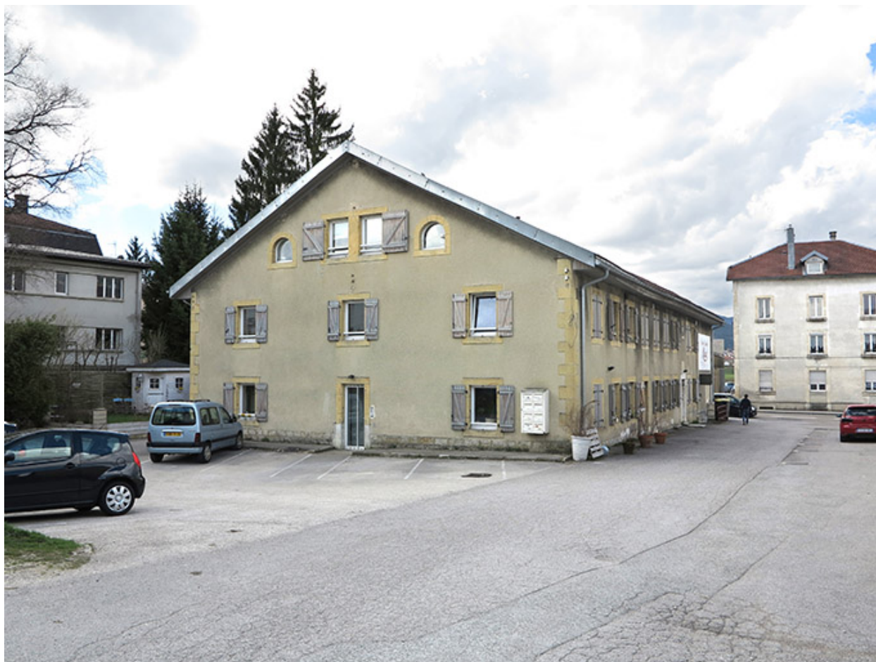
Façades postérieure et latérale gauche.
