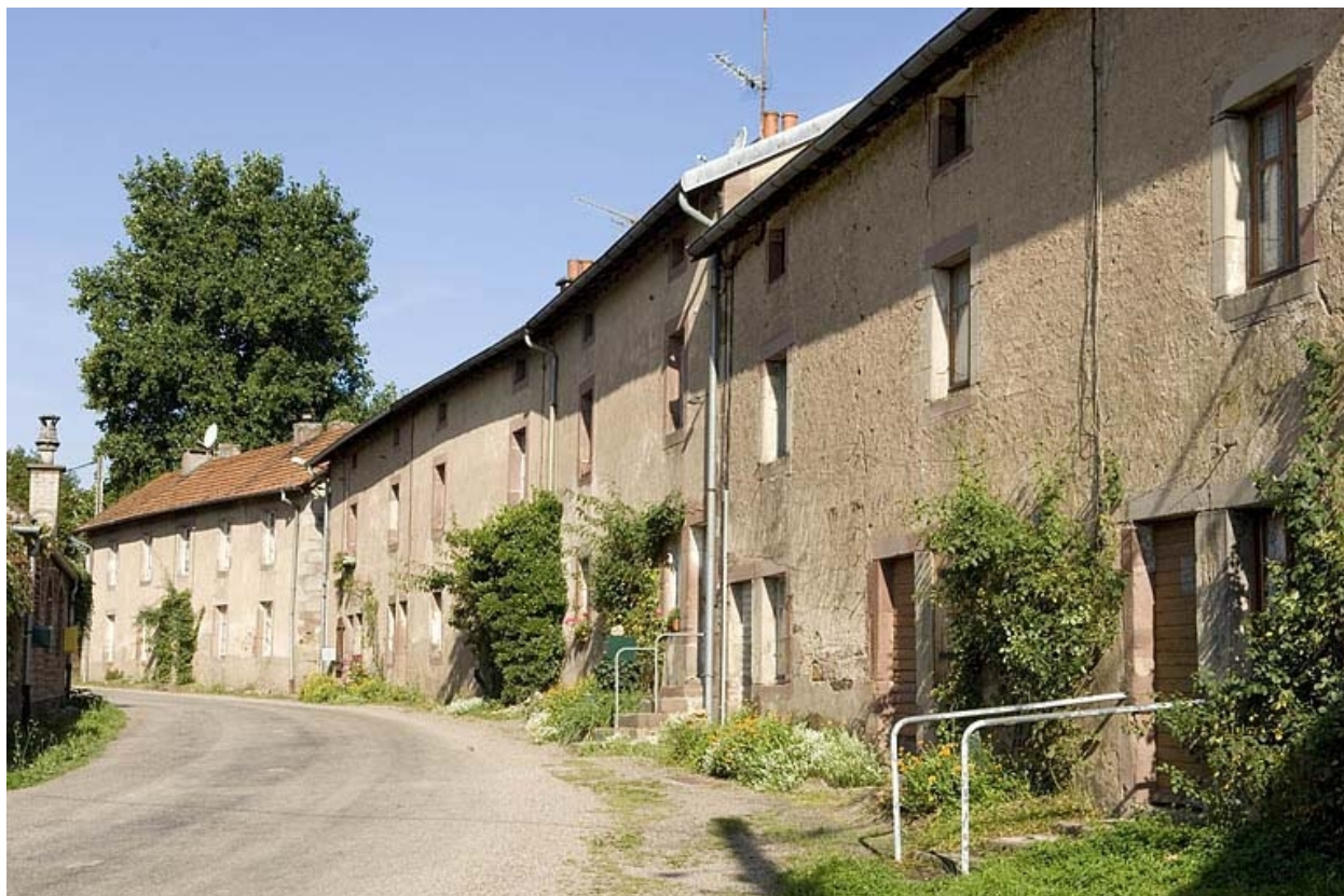
Façades de logements ouvriers (R.D. 304).
