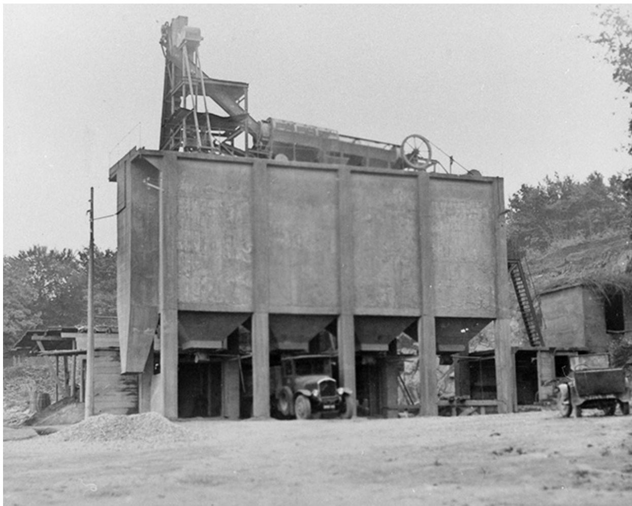
Poste de concassage (C) vu de l'ouest, 1931.
