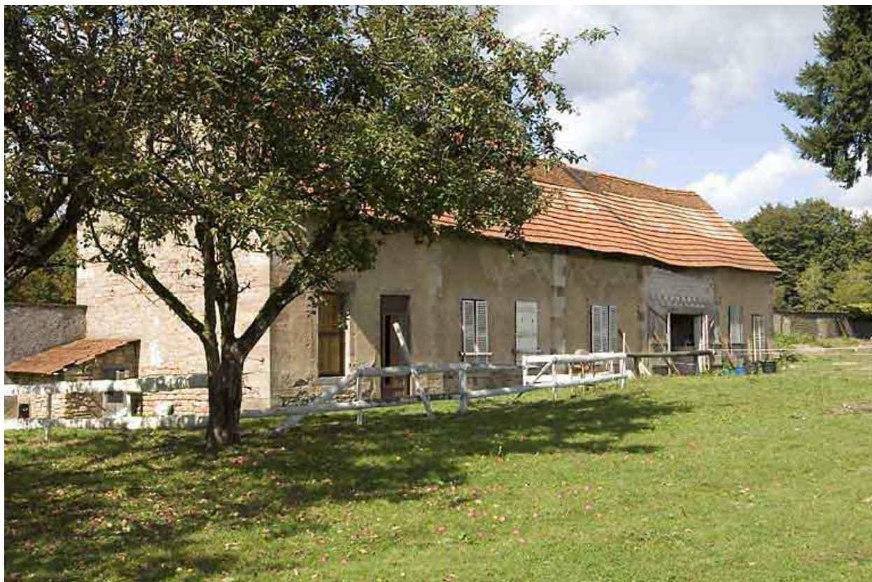
Logement ouest et parties agricoles.
