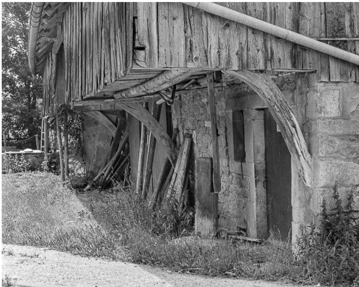
Galerie en bois protégeant un mur goutterot.
