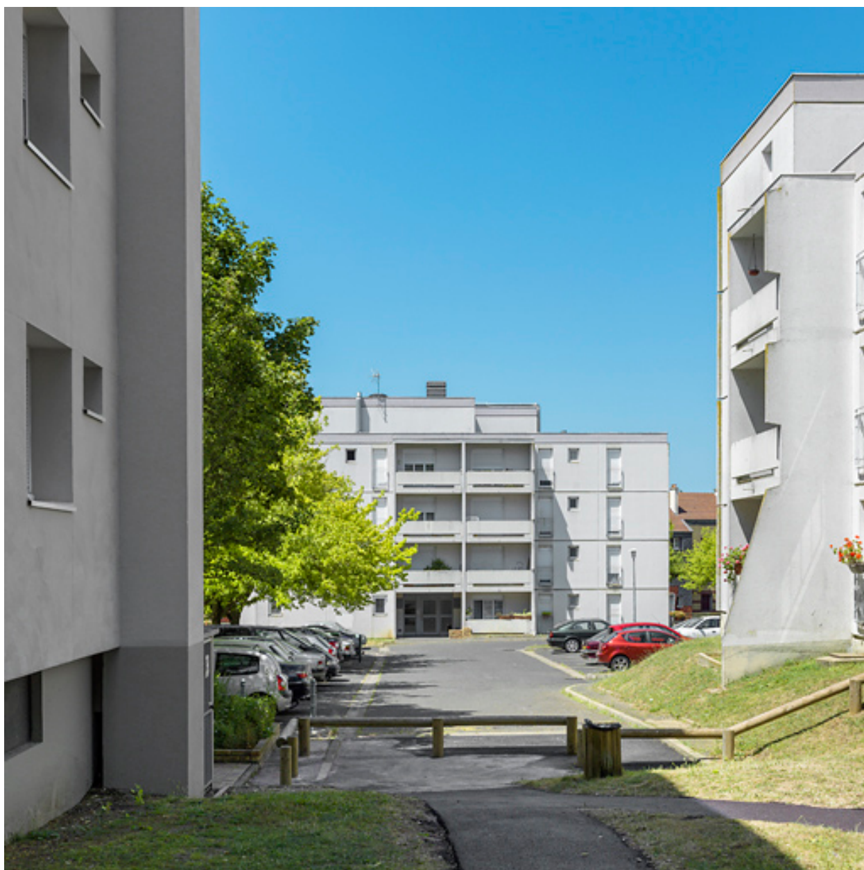
Bâtiment 27, façade antérieure.
