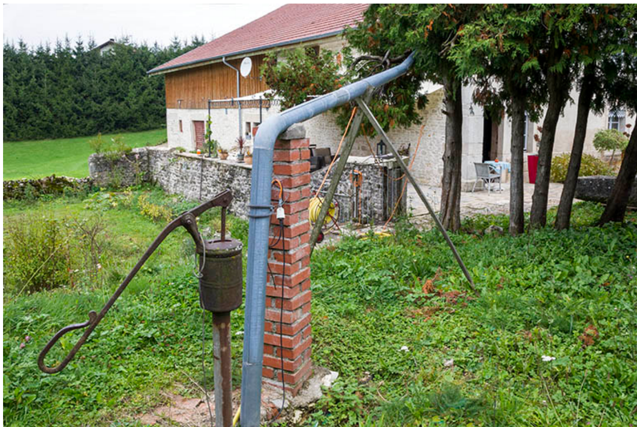
Citerne, pompe et tuyau d'amenée d'eau.
