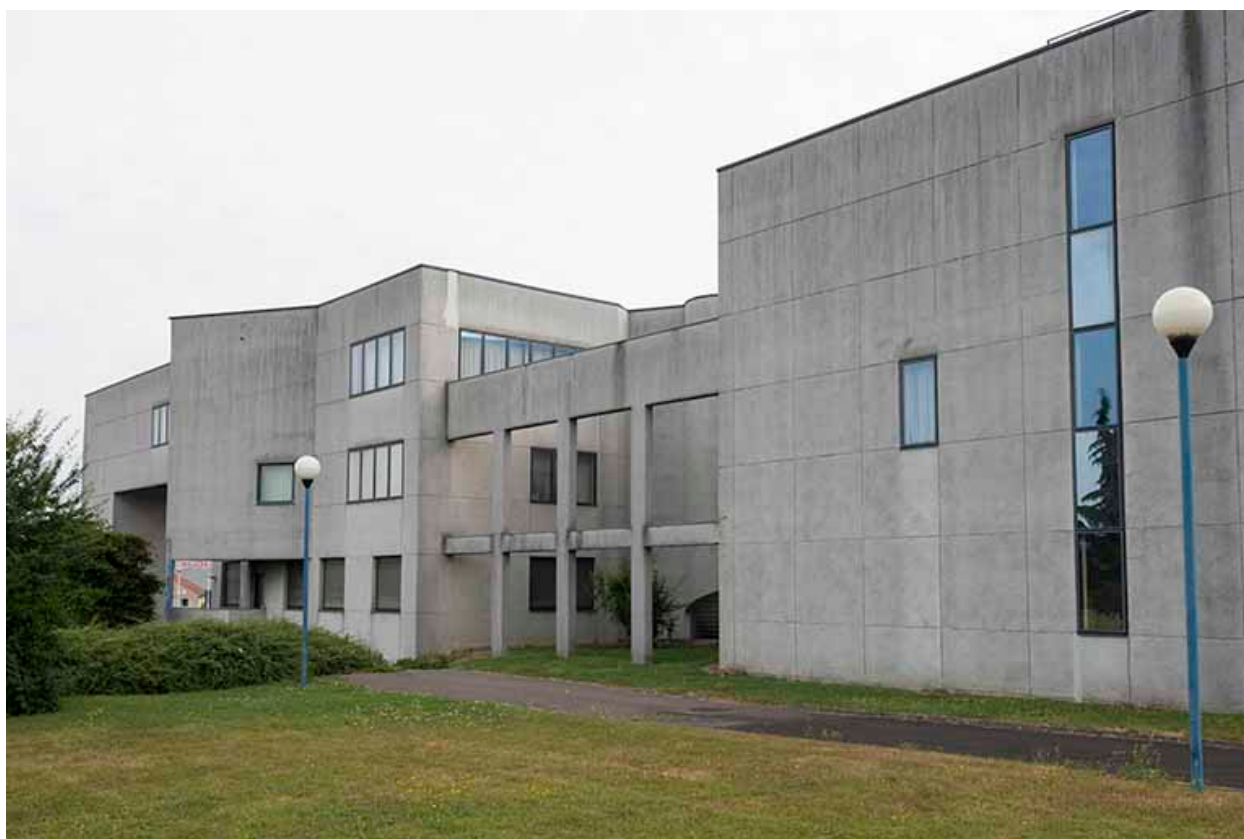
Détail au nord de la façade sud-ouest.
