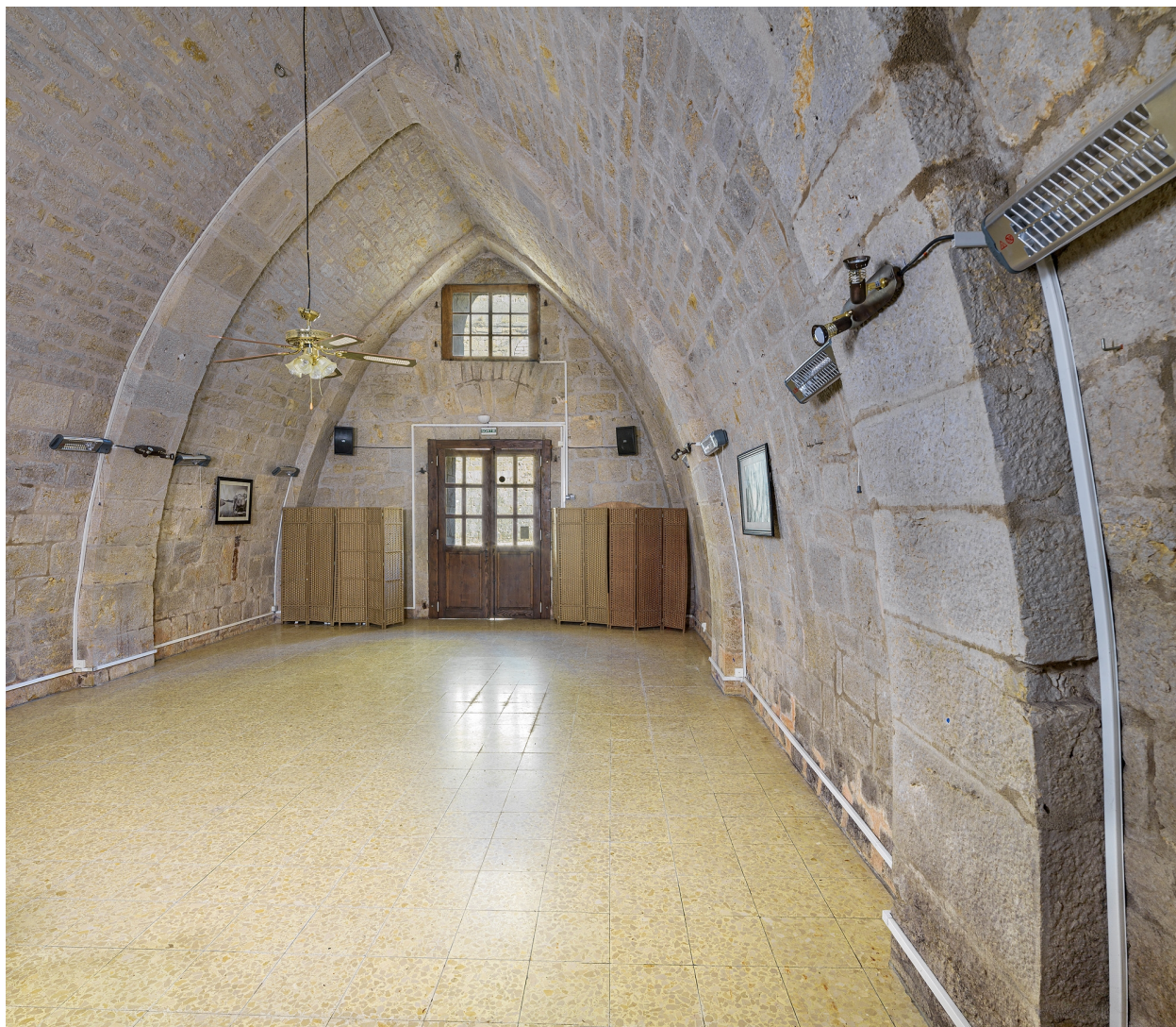
Poudrière : vue intérieure.
