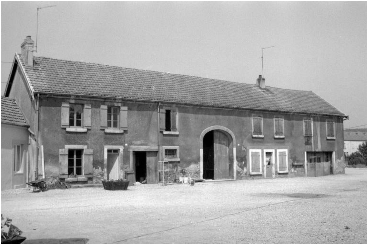
Logement d'ouvriers, écuries et fenil (C).
