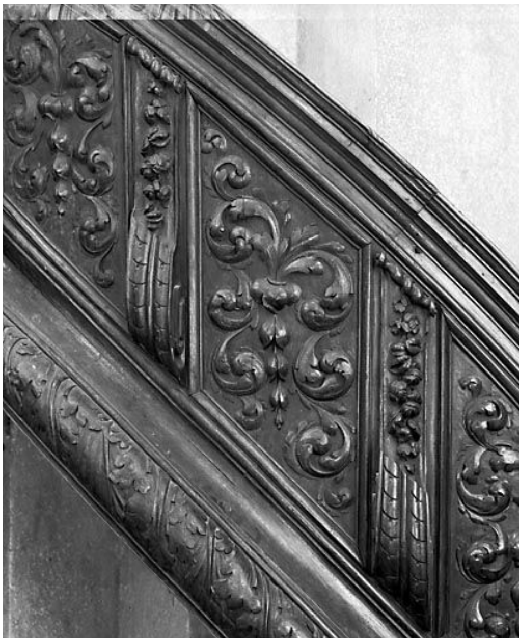
Détail de la rampe.
