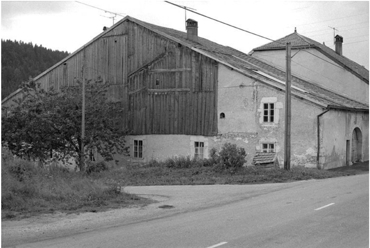
Fermes datées de 1880 et 1706, situées 15 et 15 bis avenue des Turquoises : façades antérieure et latérale gauche.
