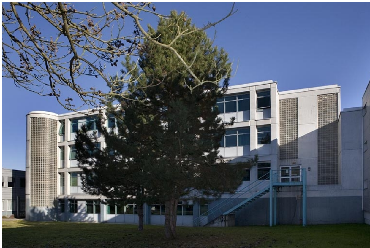
Bâtiment B. Vue de la façade antérieure.
