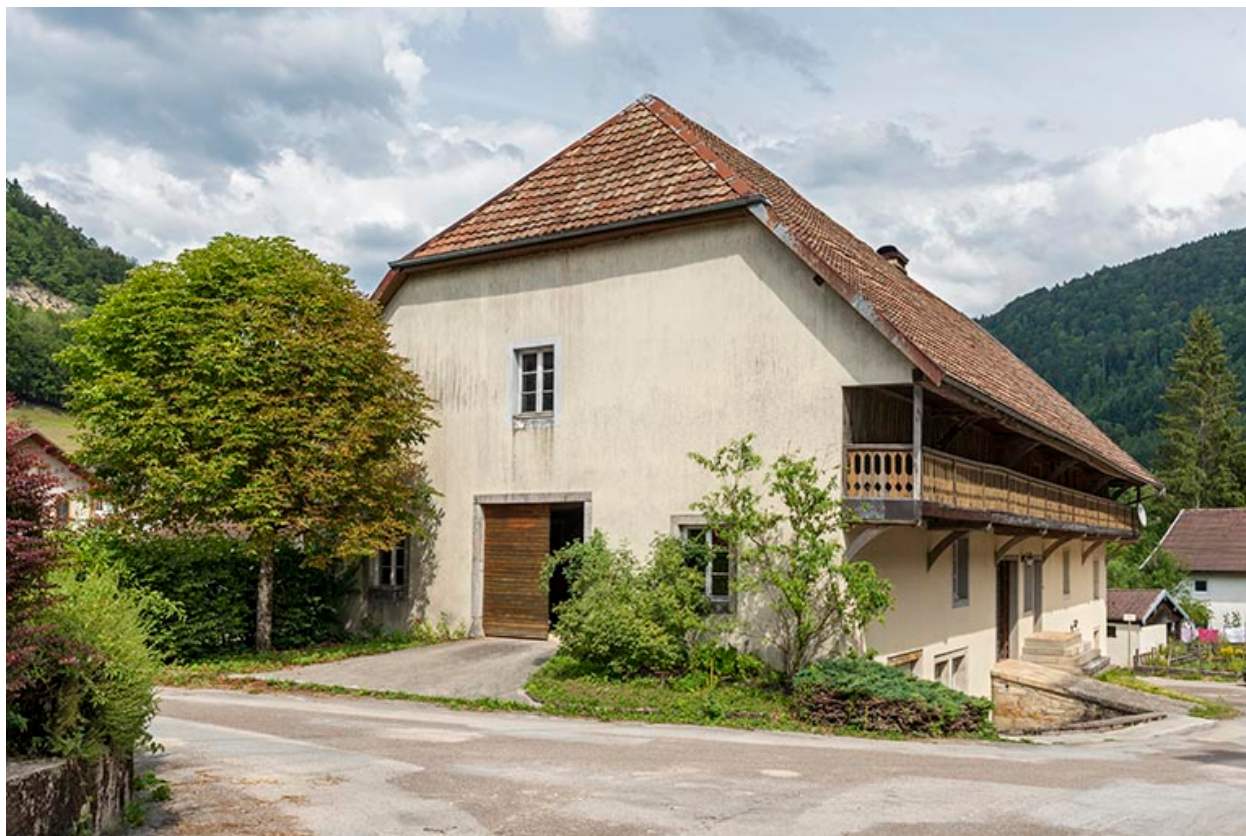
Ferme : façades antérieure et latérale gauche.
