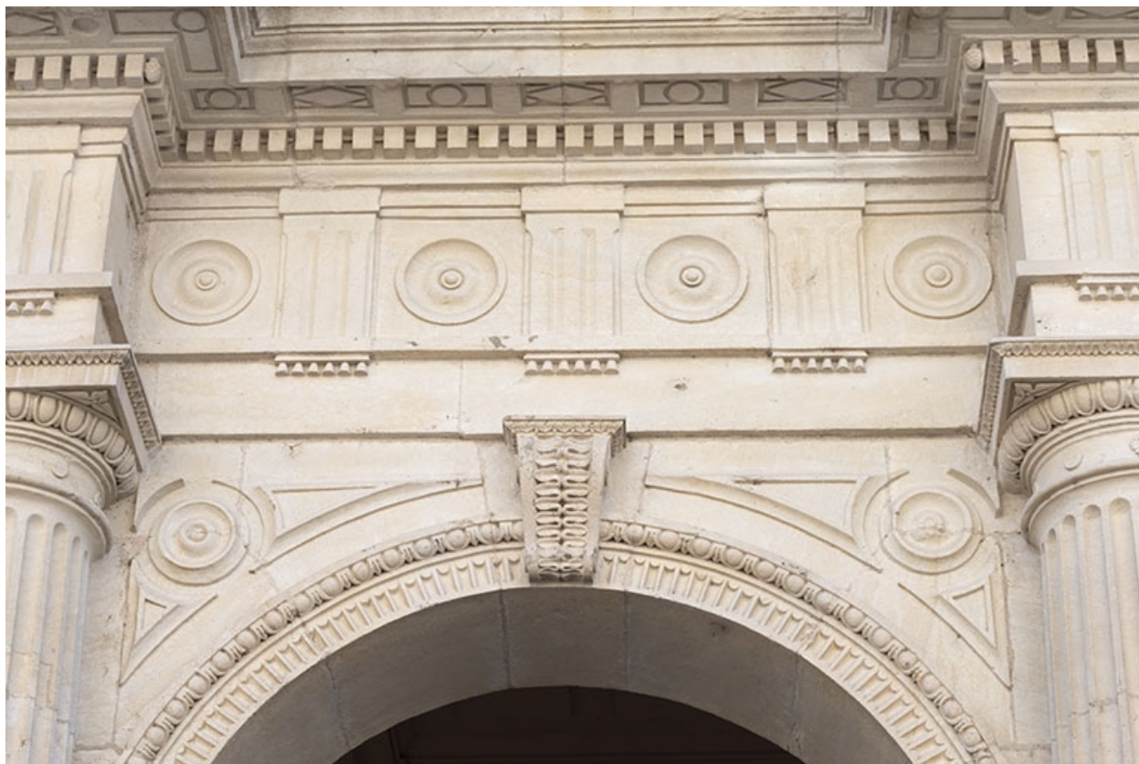
Façade antérieure, rez-de-chaussée : entablement.
