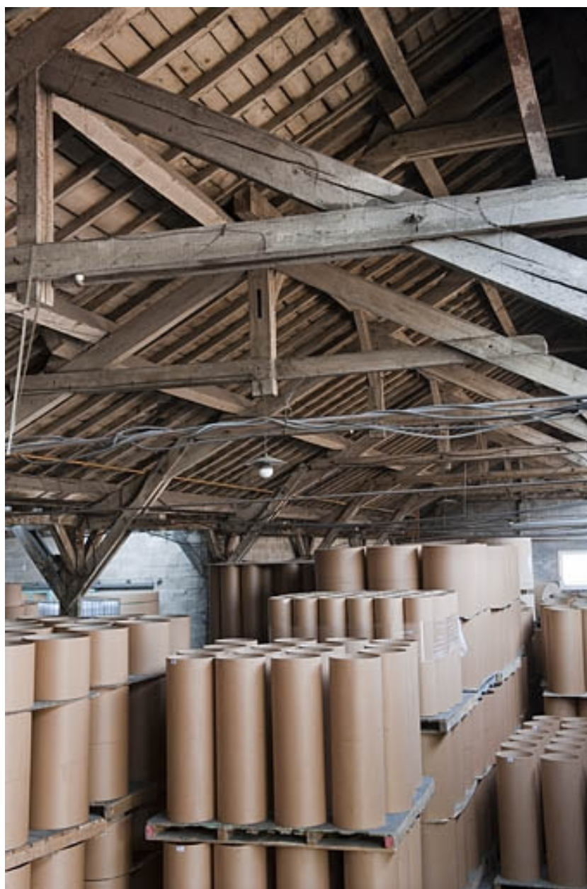
La charpente du magasin industriel (cadrage vertical).
