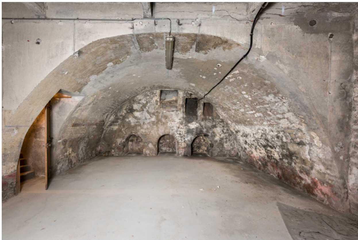
Caves nord : vue depuis l'est.
