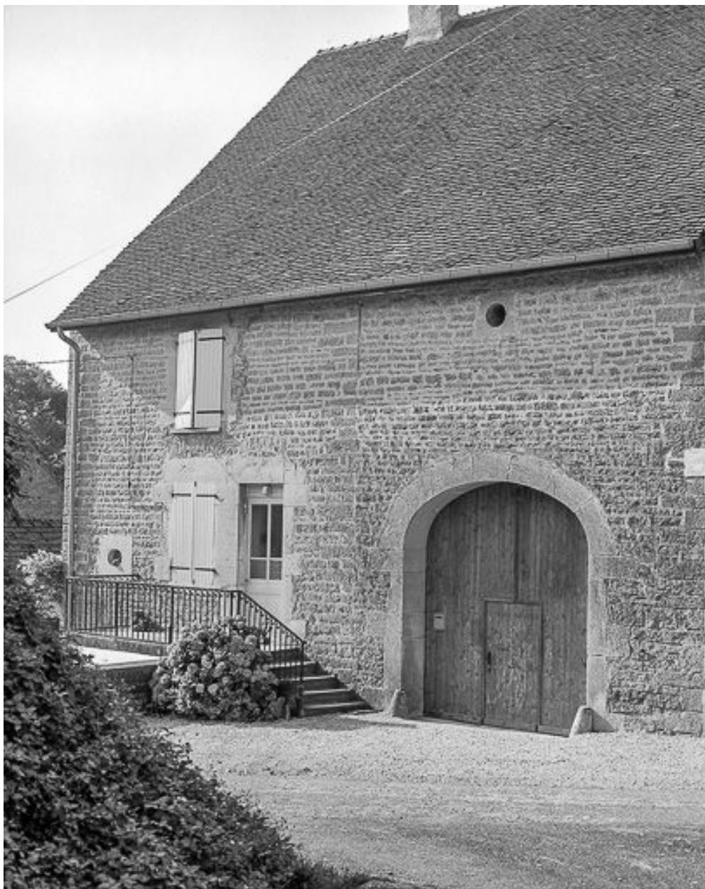
Ferme située rue du Bas du Village.
