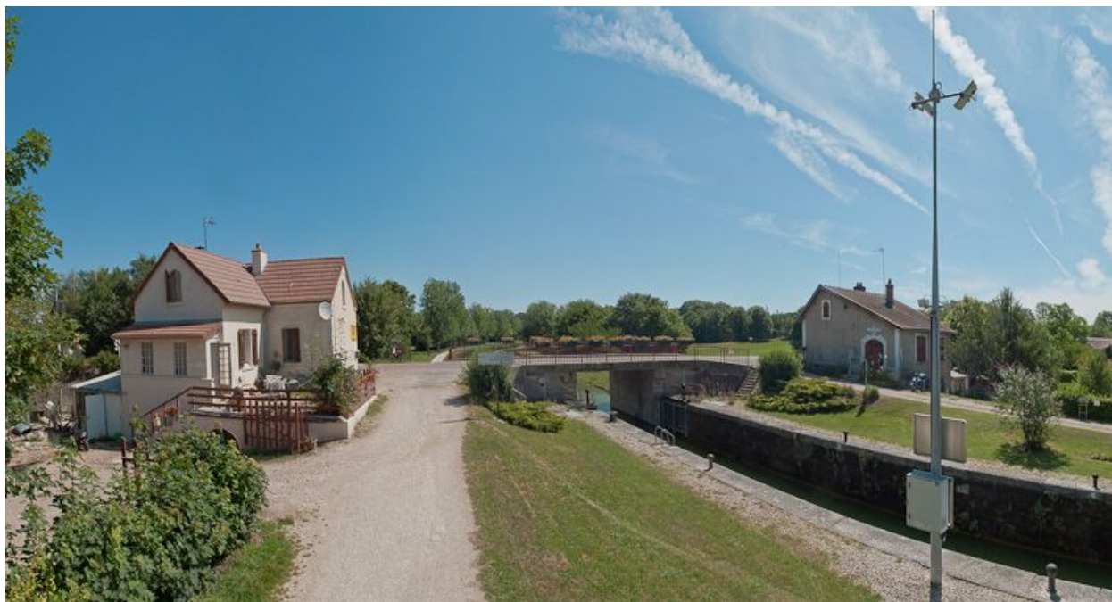
Vue d'ensemble du site d'écluse.
