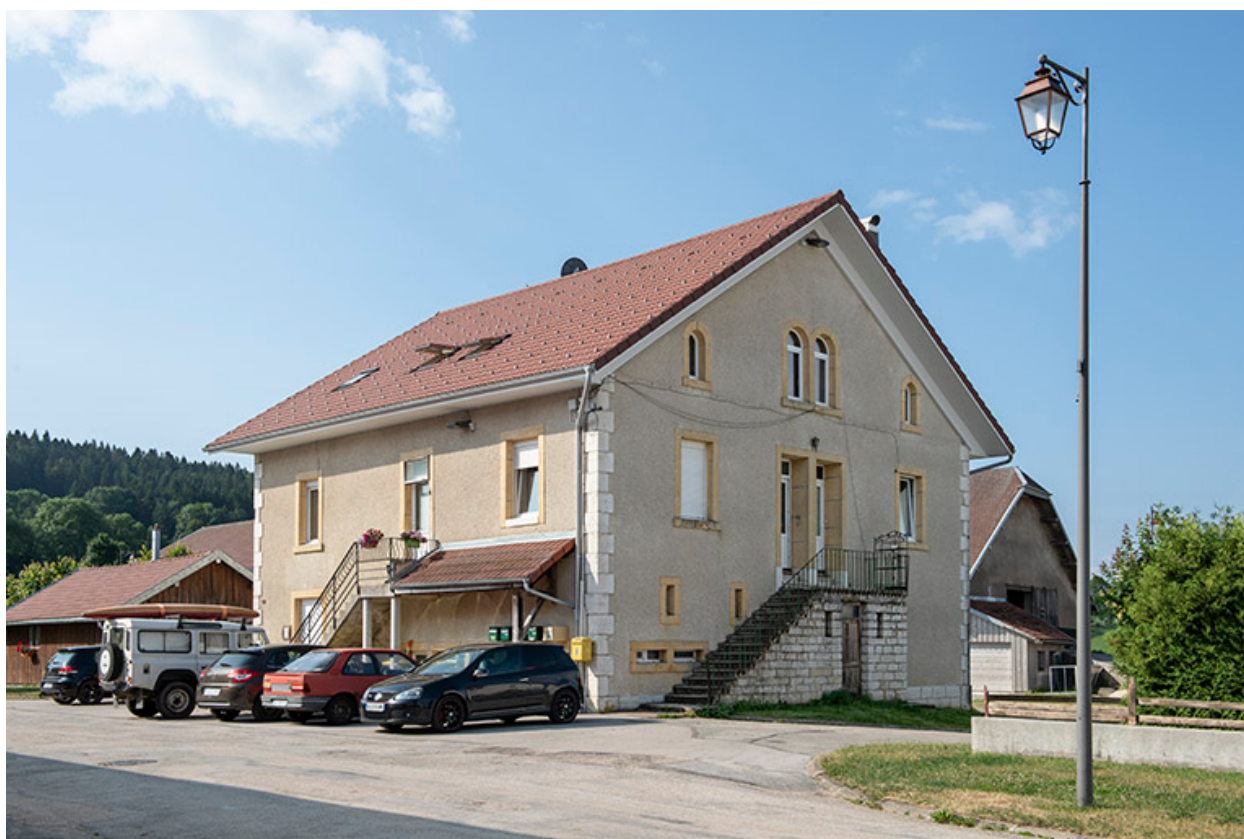
Façades nord et est.
