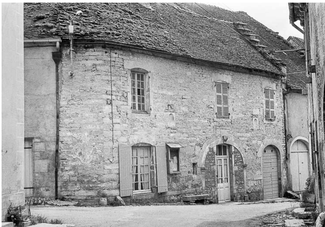
Maison située rue de l'Eglise.
