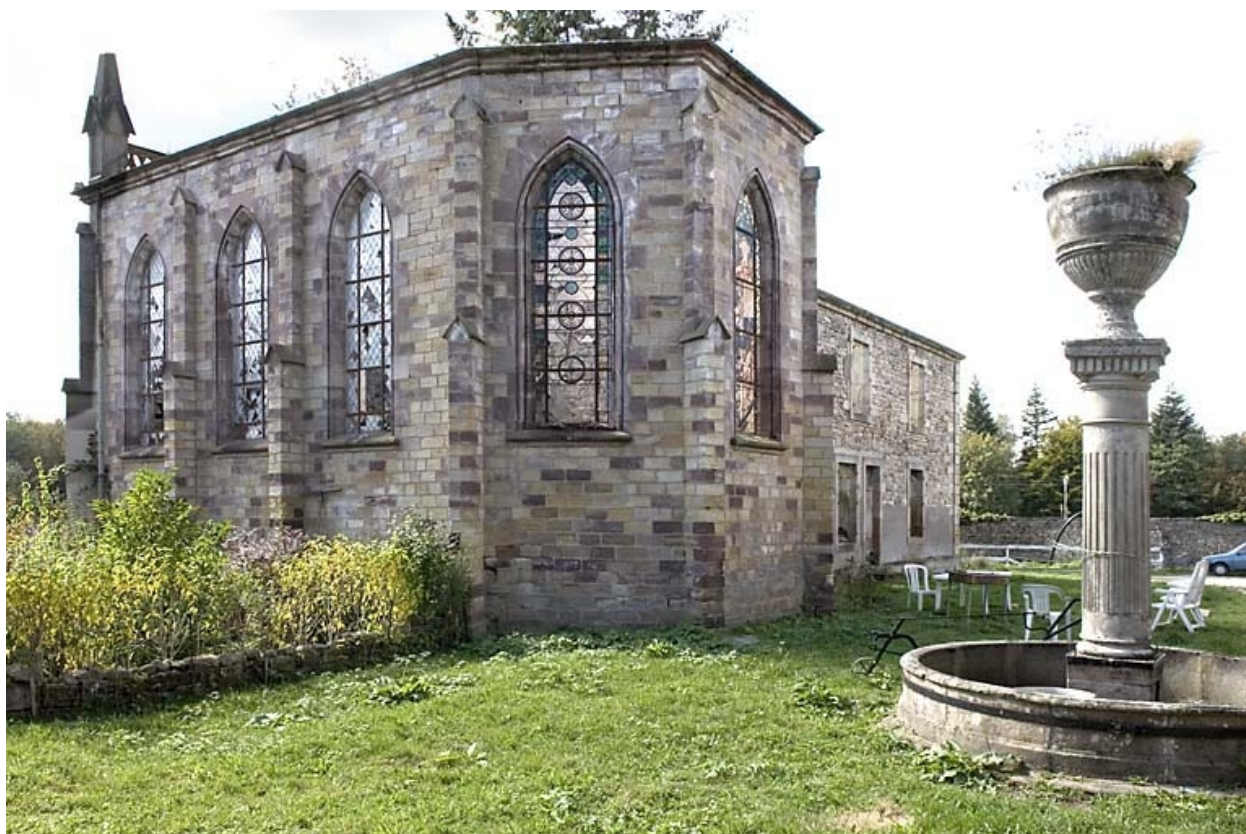
La chapelle, vue de trois quarts arrière.
