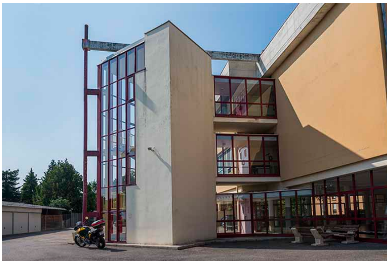
Détail de l'escalier dit le phare.
