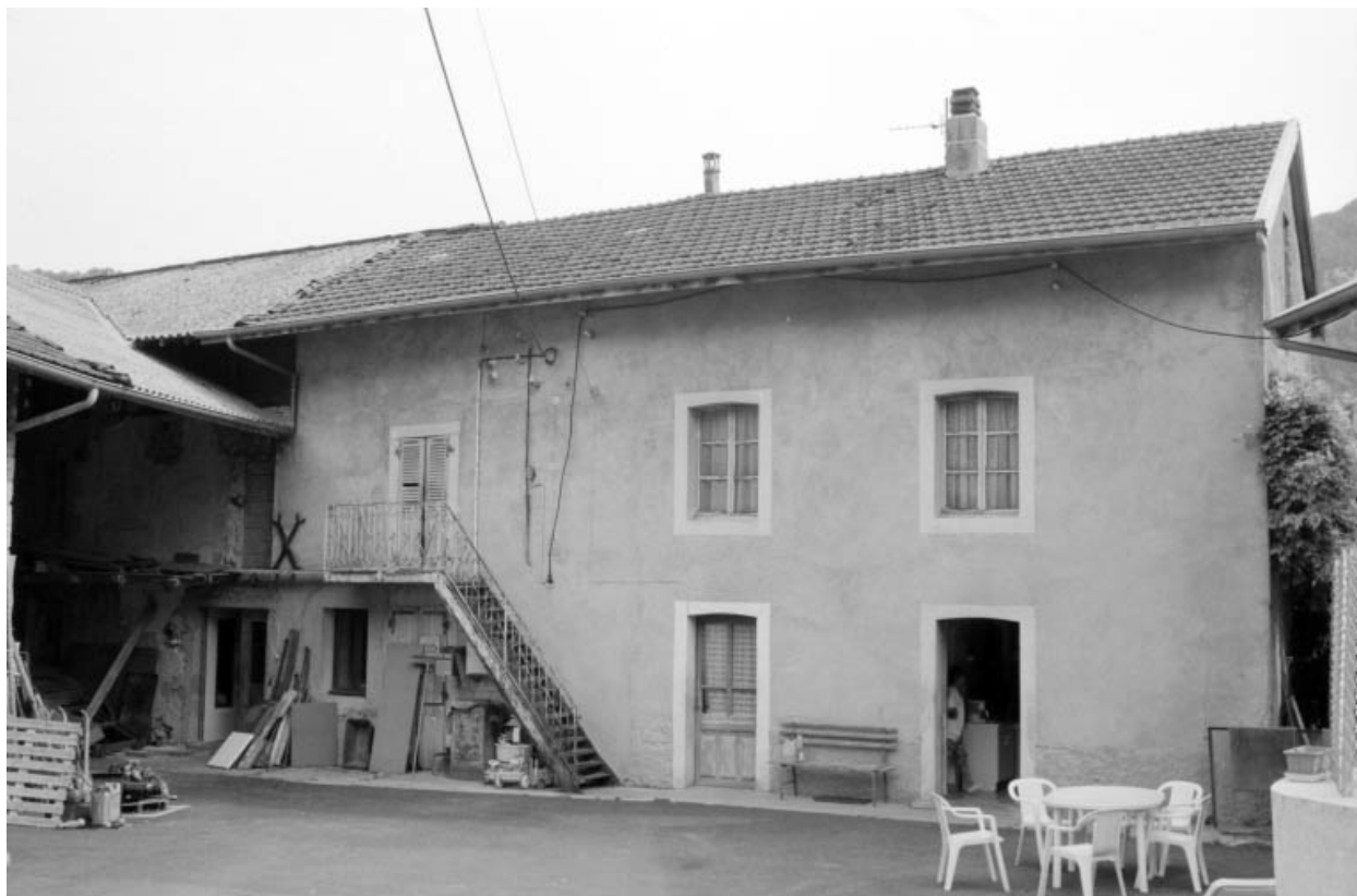
Façade antérieure du logement.
